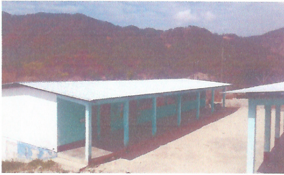
Foto 1: Mejoramiento de losa del patio del Centro Educativo
