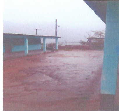
Foto 2: Mejoramiento de losa del patio del Centro Educativo
