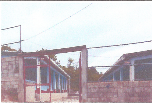
Foto 3: Mejoramiento de canales y bajada de agua pluvial
