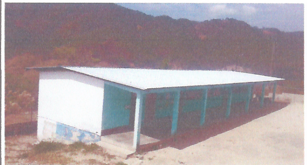
Foto 4: Mejoramiento de repello y cernido de paredes
